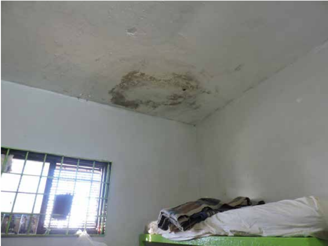
Desafío - Humedades y filtraciones de celda
