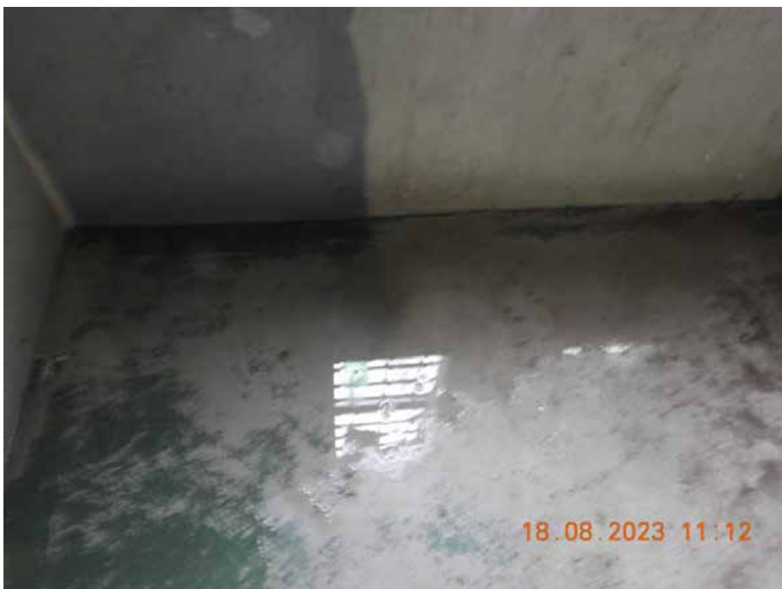
CIAM - Ingreso de agua por lluvias en celdas sin acrilico o protección en ventanas
